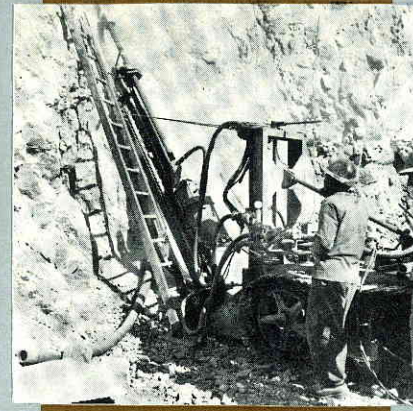
E 9 beim Fächerbohren auf Sizilien
