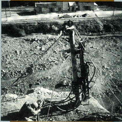
DK 9 an abgespannter Säule
