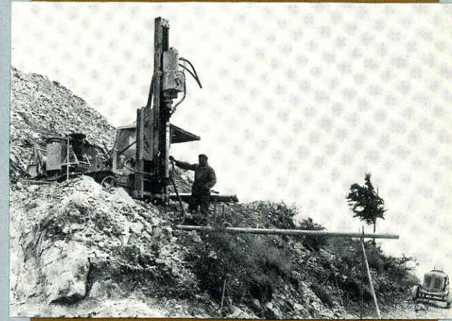
E 9 beim Sprenglochbohren im Steinbruch
