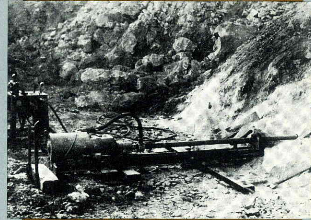
E 9 ohne Unterbau im Einsatz für Sohlenbohrungen
