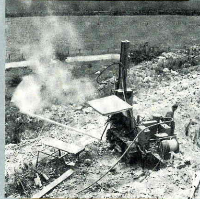
E 9 ohne Unterbau im Einsatz für Sohlenbohrungen
